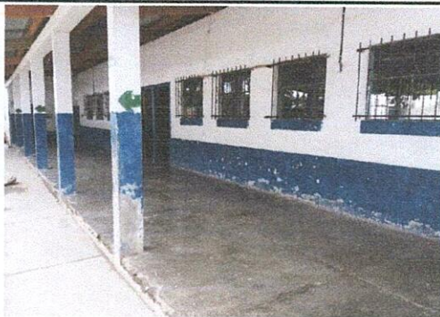
Foto 5: Mejoramiento de pintura en muros exterior de aulas
