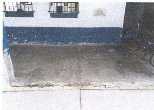
Foto 4: Mejoramiento de piso de corredor frente a aulas de módulo 3
