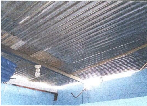
Foto 3: Mejoramiento a cubierta de lámina
