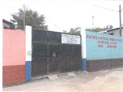
Foto 2: Mejoramiento y Techado del porton
